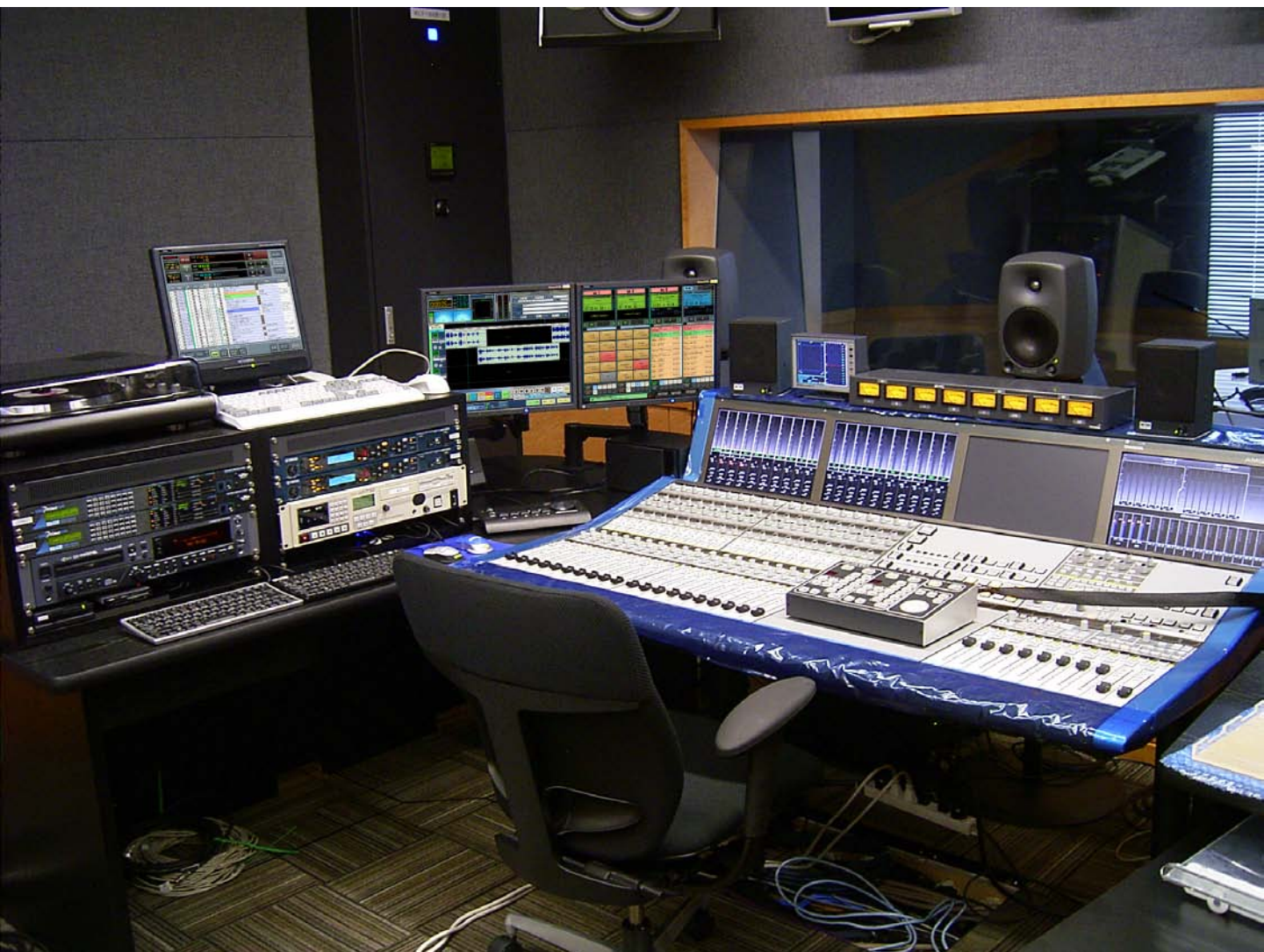
(株)エフエム福岡殿スタジオ設置
